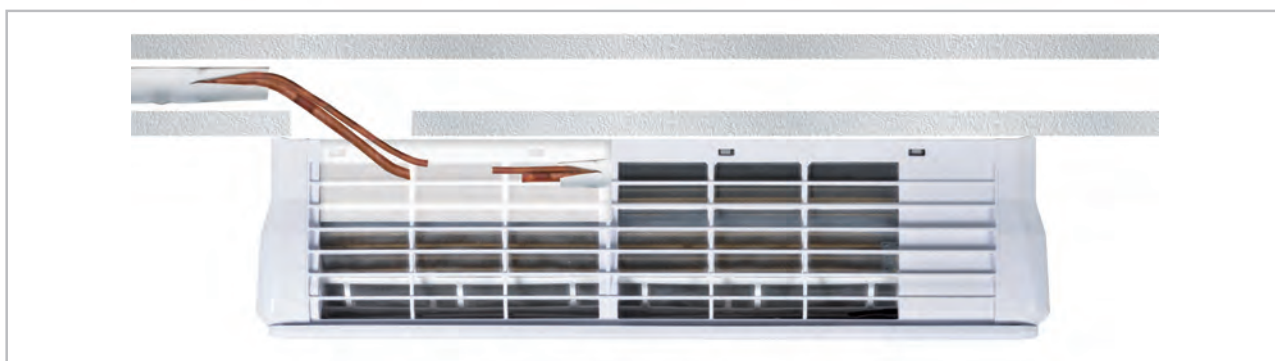
Abb. 10: Unterputzinstallation der Kältemittelleitungen (Ansicht von oben)
